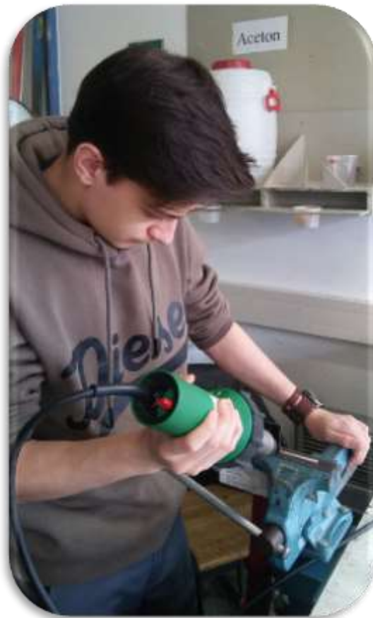
Abbildung 11: Vorbereitung der Ablaufrinne
